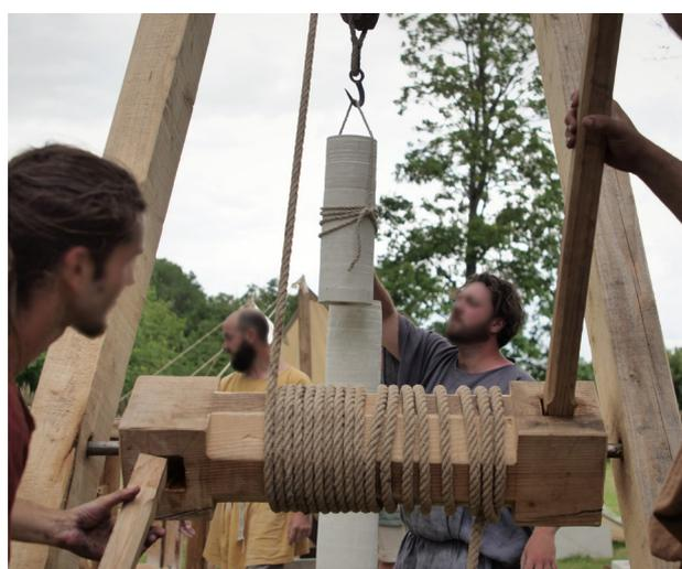
**Fig. 17** : Mise en place de la colonne à l'aide de la chèvre de levage. Crédit C. Billault.
