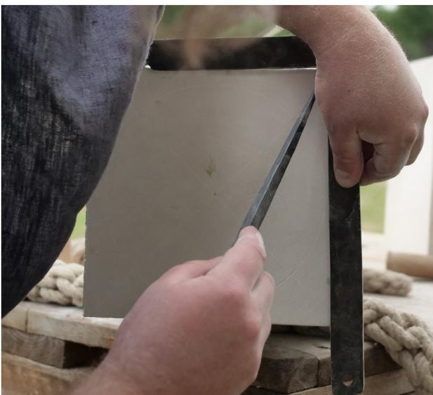
**Fig. 4 :** Tracé des axes et du centre à la pointe et à l'équerre. Crédit C. Billault.
