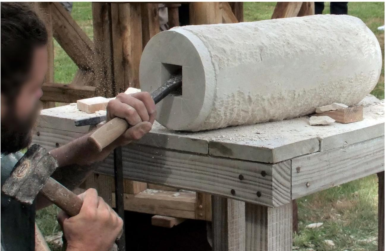
**Fig. 11 :** Réalisation d'une mortaise au ciseau plat, sur un bloc pourvu d'une ciselure circulaire. Crédit C. Billault.
