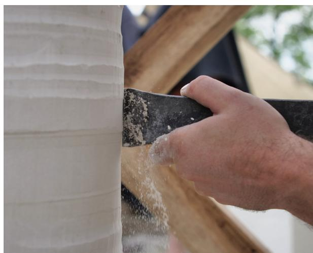
**Fig. 12** : Dégrossissage par abrasion au ciseau plat. Crédit C. Billault.
