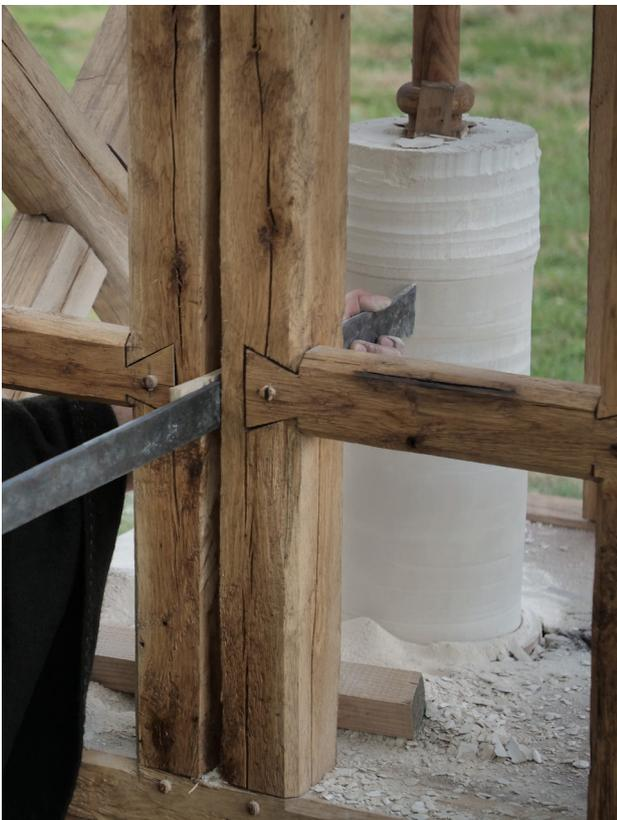
**Fig. 13** : Tournage au ciseau plat avec cale. Crédit C. Billault.
